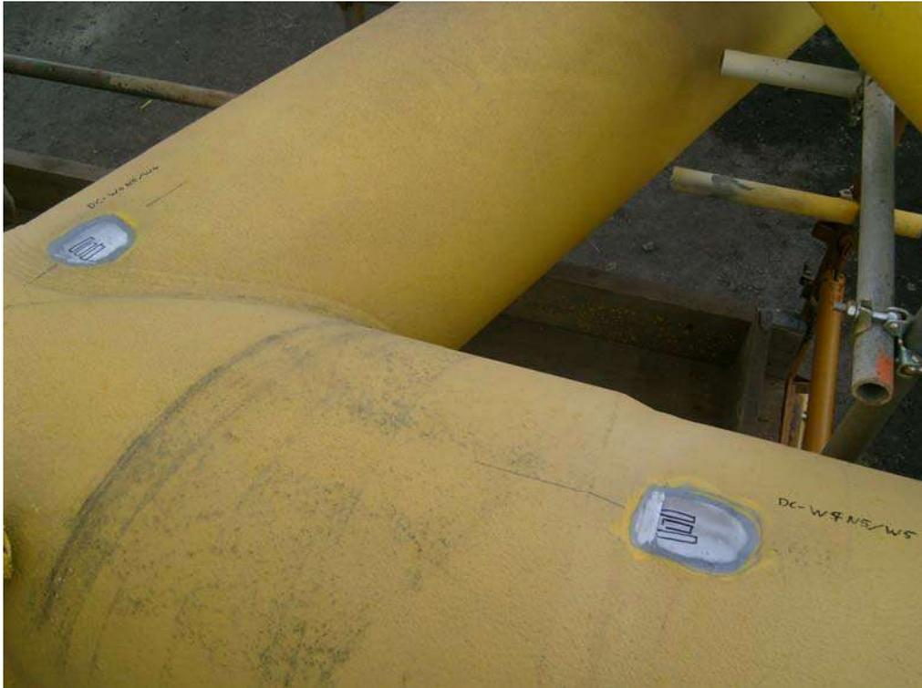
Abbildung 1: DMS-Position angezeichnet und angeschliffen
