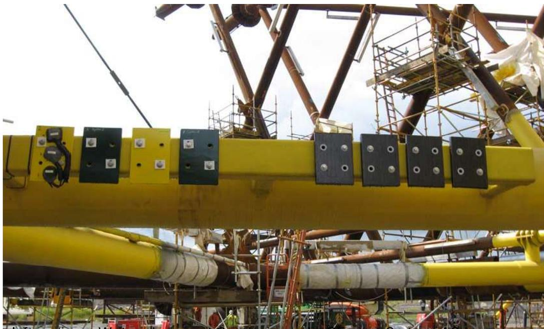
**Abbildung 2: Test-Coupons E.II-IV bis E.II-VIII**
