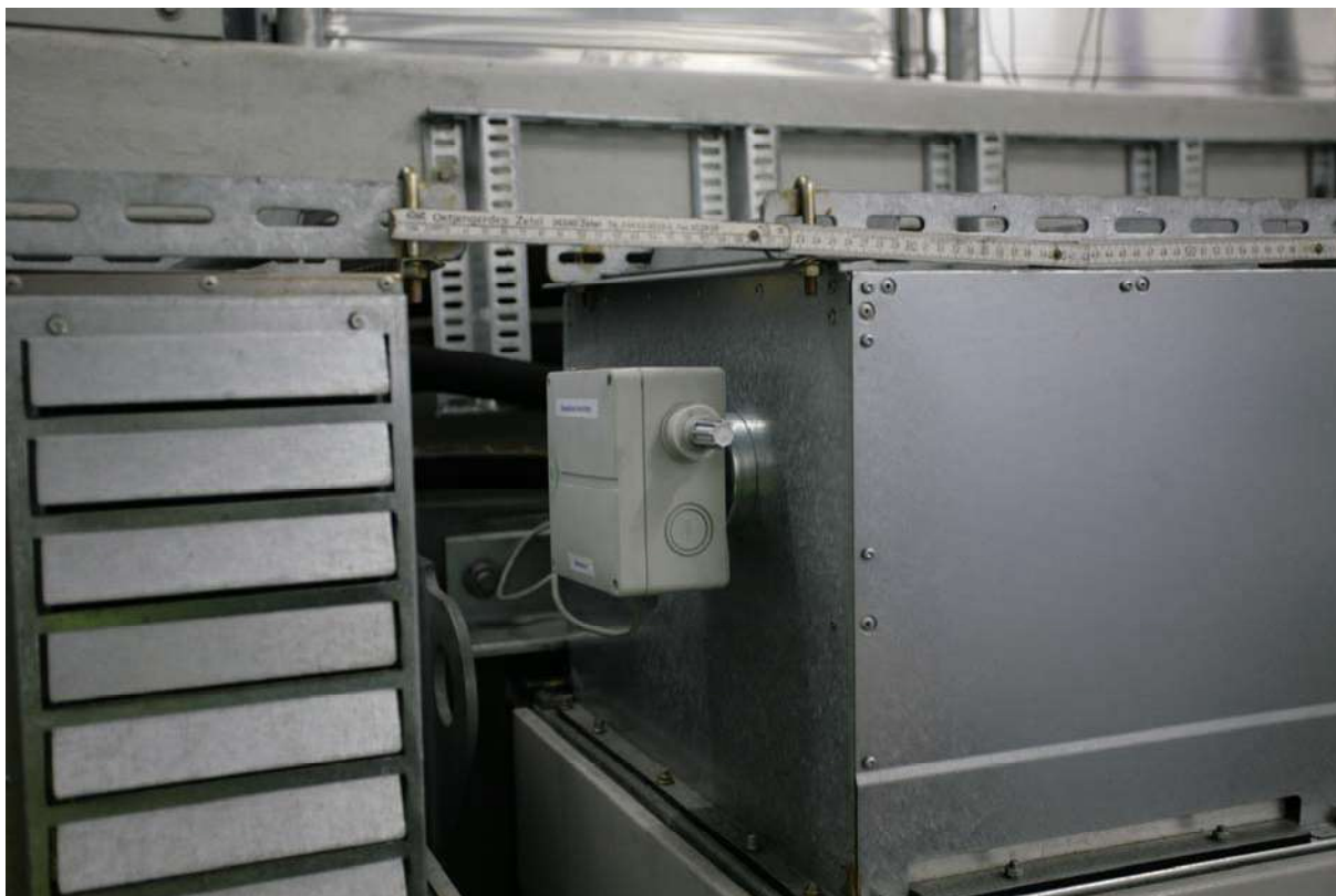
Abbildung 4: Sensorposition an Umrichter
