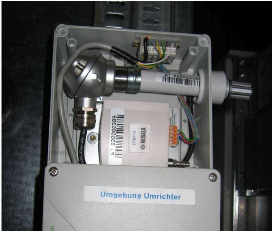
Abbildung 1: Drucksensor und Anschlussbox
