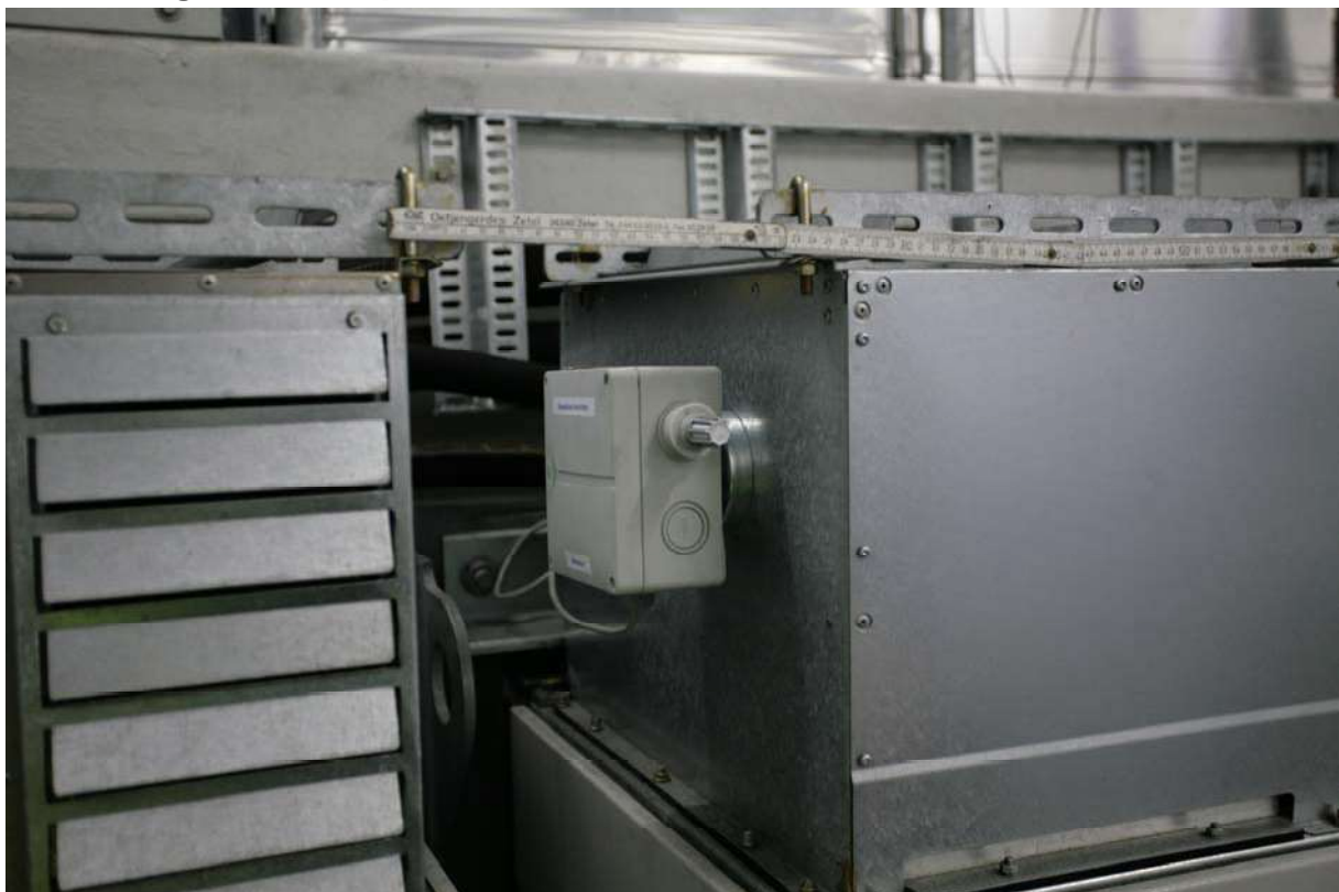
Abbildung 4: Sensorposition an Umrichter
