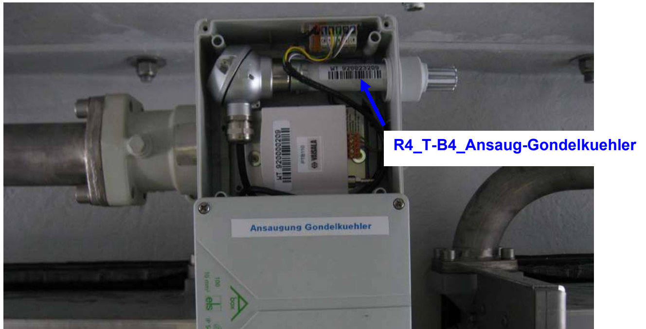
Abbildung 1: Temperatursensor in Anschlussbox
