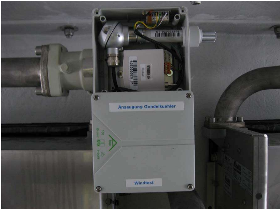
Abbildung 1: Drucksensor und Anschlussbox
