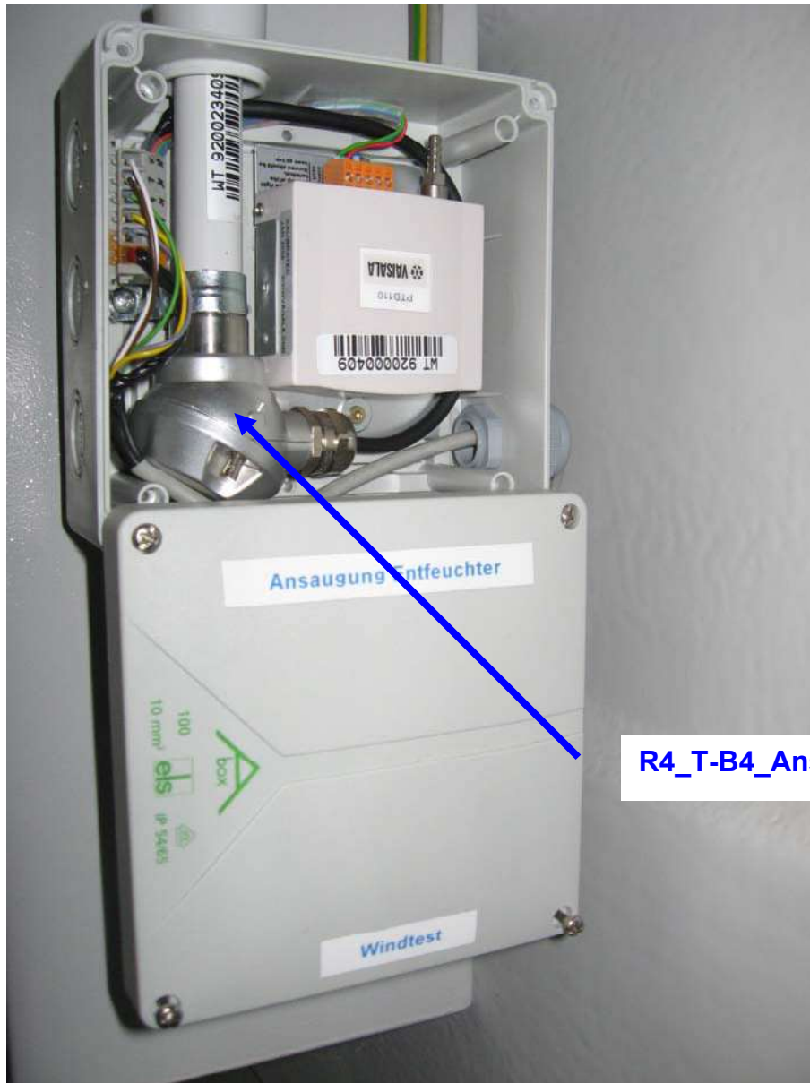
Abbildung 1: Temperatursensor Verdrahtung
