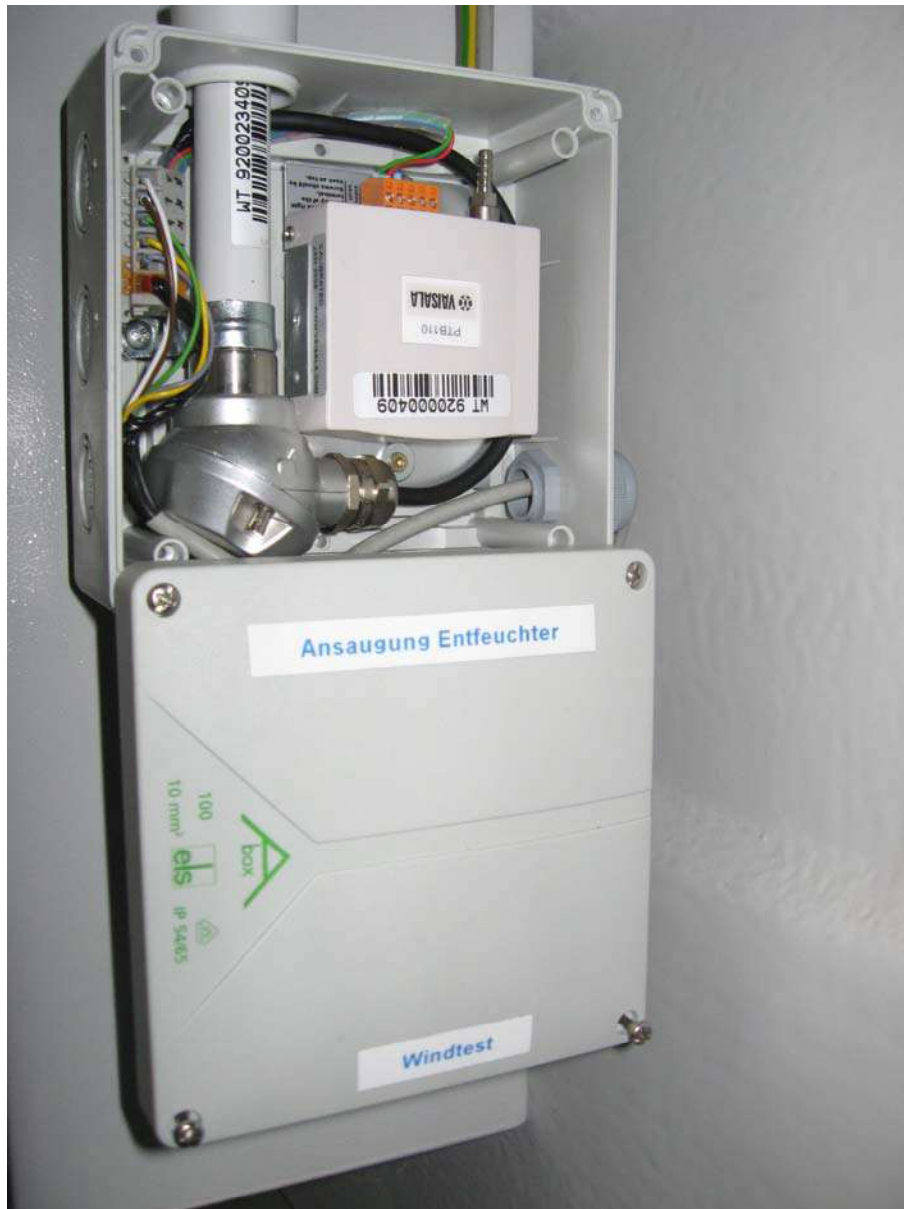
Abbildung 1: Drucksensor und Anschlussbox
