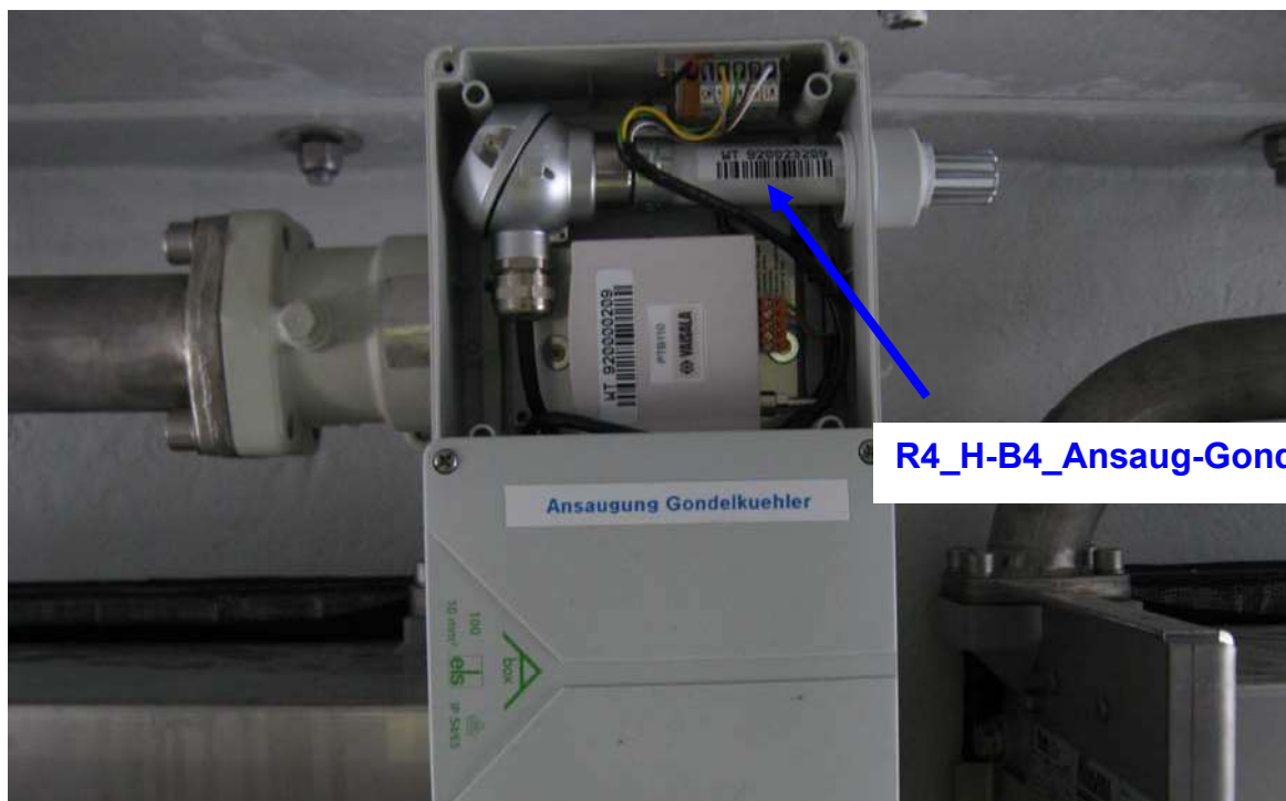
Abbildung 1: Feuchtesensor in Anschlussbox
