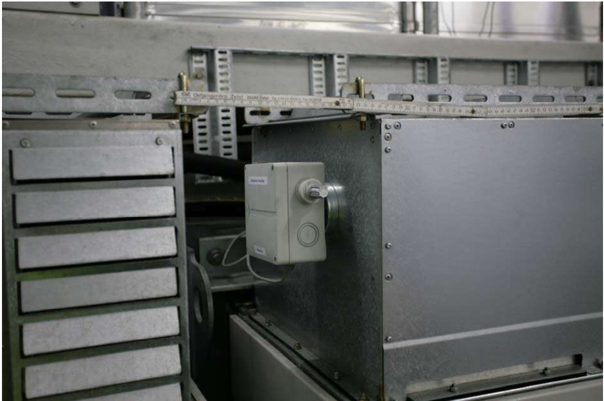
Abbildung 4: Sensorposition an Umrichter
